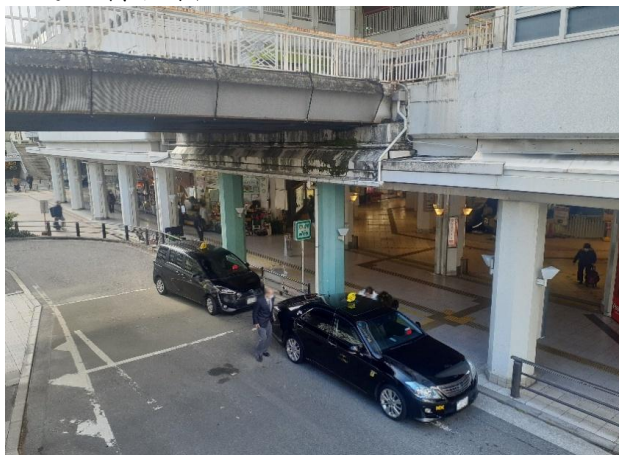
<巡回時、現場状況>
