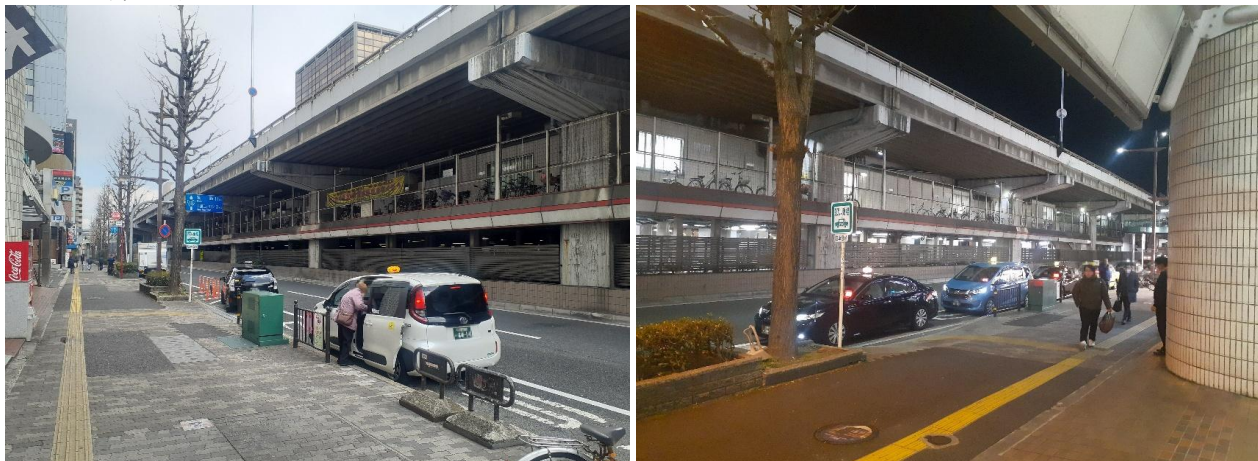
< 巡回時、現場状況 >
